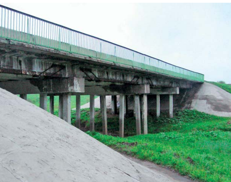
Общий вид до капитального ремонта моста через реку Тоймина км 299+185 автомобильной дороги М-8 «Холмогоры»
