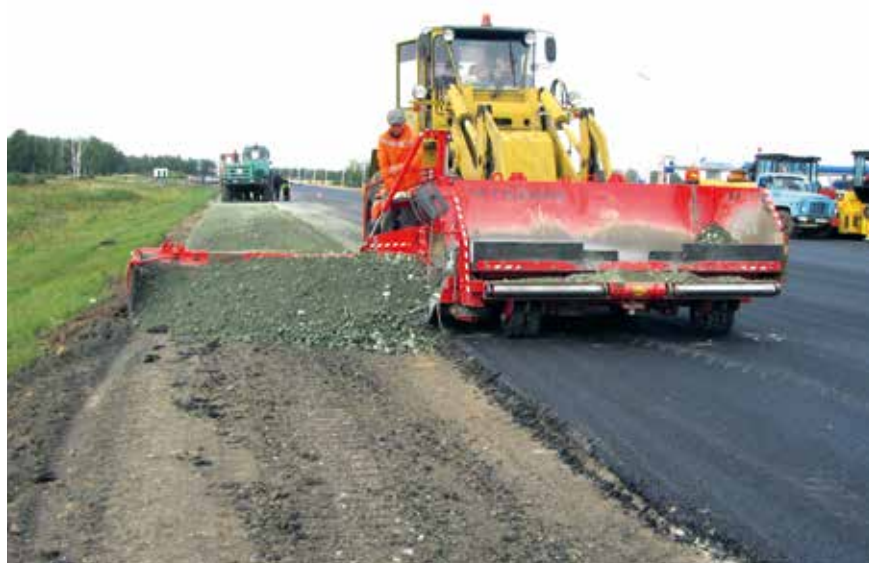
▲ Укрепление обочин ЩПС на ремонте М-51 Байкал
