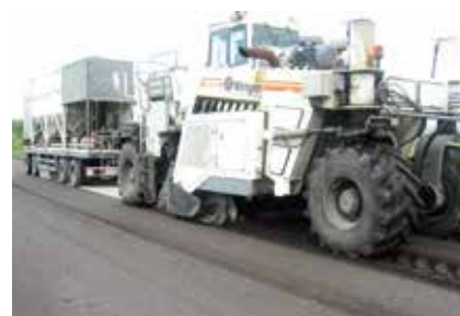
▲ Ресайклирование сущ. дорожной одежды с добавлением цемента на а-дороге 1 Р 402 Тюмень – Омск
