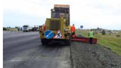
▲ Ресайклирование сущ. дорожной одежды с добавлением цемента на а-дороге 1 Р 402 Тюмень – Омск
