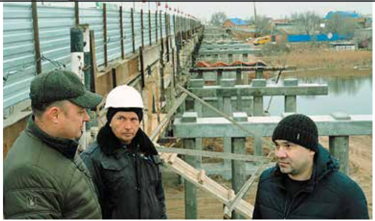
Вячеслав Солопов на реконструкции Милицейского моста
