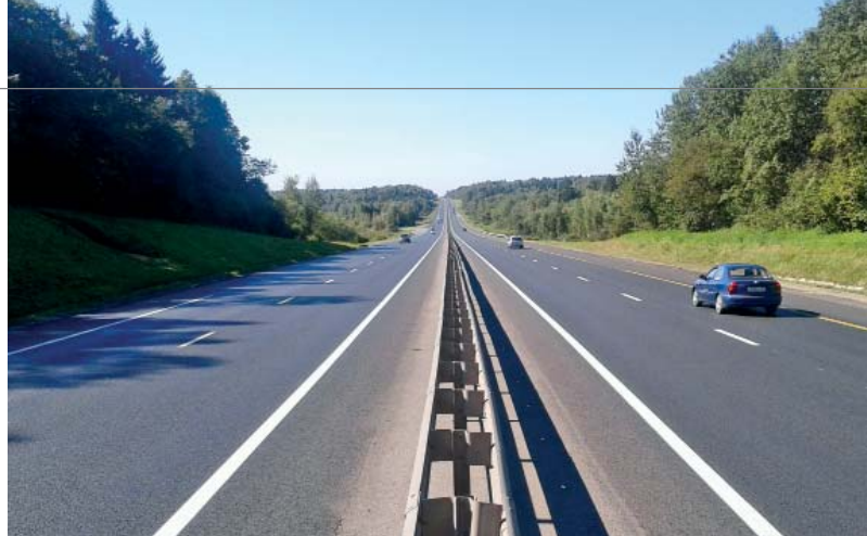
Автомобильная дорога М-8 «Холмогоры» км 68+500 – км 95+300
