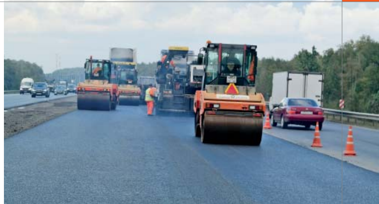
Укладка верхнего слоя покрытия из щебеночно-мастичной а/б смеси ЩМА 19 на участке автомобильной дороги М-2 «Крым» км 58+000 - 63+000
