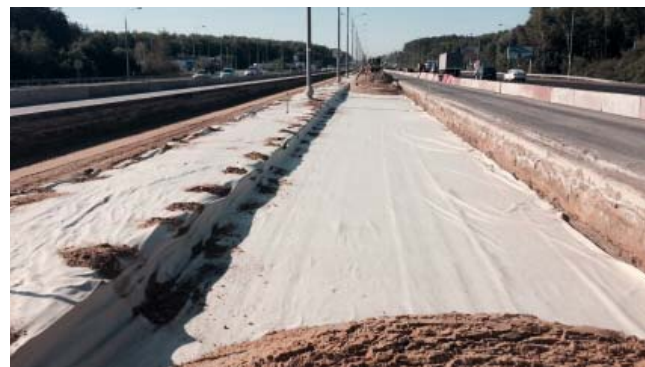
Капитальный ремонт автомобильной дороги М-2 «Крым» км 49+000 - 65+000
