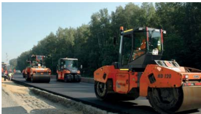
Укладка нижнего слоя покрытия из мелкозернистой плотной а/б смеси SP 19 на участке автомобильной дороги М-2 «Крым» км 59+100 - 61+800
