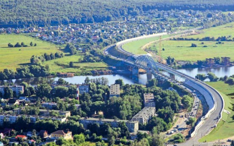
Реконструкция моста через р. Москва на км 25 + 591 автомобильной дороги ММК (участок от Егорьевского шоссе до Рязанского шоссе)
