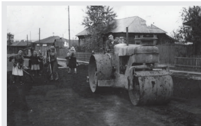
Укладка асфальта на дороге Талица - Поклёвская
