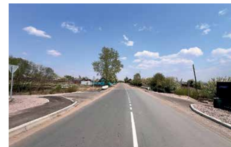
Автомобильная дорога Балей-Каменка
