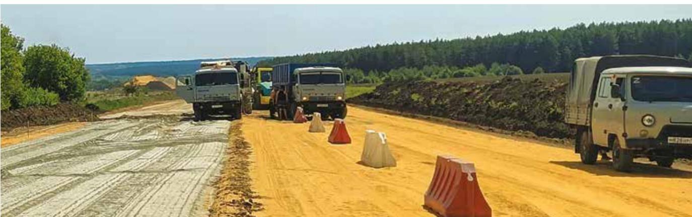
Так как участок давно пришел в негодность и был полностью разрушен, было решено устроить конструкцию дорожной одежды с использованием стабилизации существующих грунтов и обработке слоя основания неорганическим вяжущем методом холодного ресайклинга.
