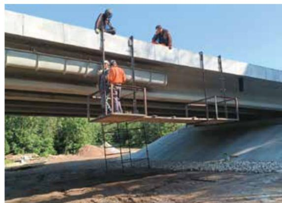
На всех объектах специалисты РЭМ-34 выполняют примерно аналогичные виды работ, это снятие старого асфальтобетонного покрытия, ремонт пролетных строений, опор, ремонт укрепления конусов, устройство нового асфальтобетонного покрытия, перильного и барьерного ограждения.
